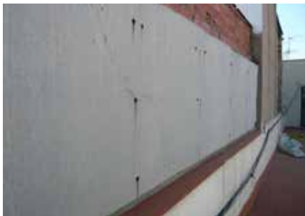
Figura 5. Placas lisas de fibrocemento atornilladas a madera.
