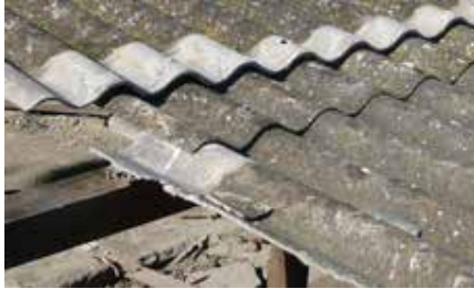
Figura 4. Placas onduladas de fibrocemento atornilladas a madera.
